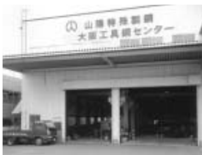
山陽特殊製鋼の工具鋼在庫販売の大阪拠点となっている大阪工具鋼センター
